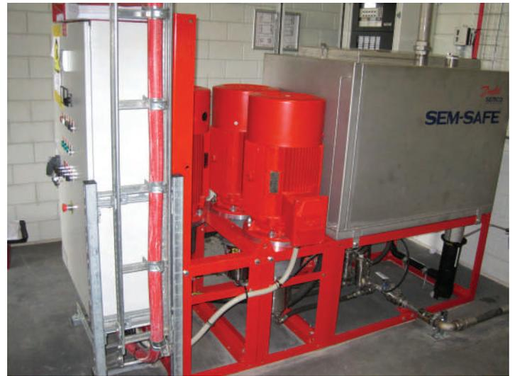
Equinix AM3 安裝的緊湊型 SEM-SAFE® 泵浦裝置。
