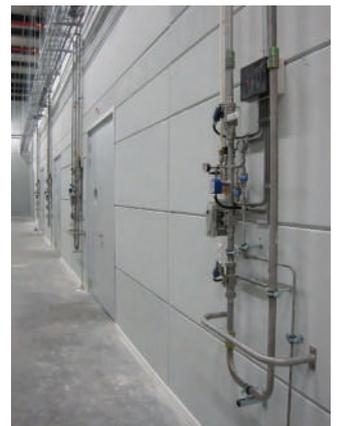
Equinix AM3 中的 SEM-SAFE® 預作用隔離閥佈置。
