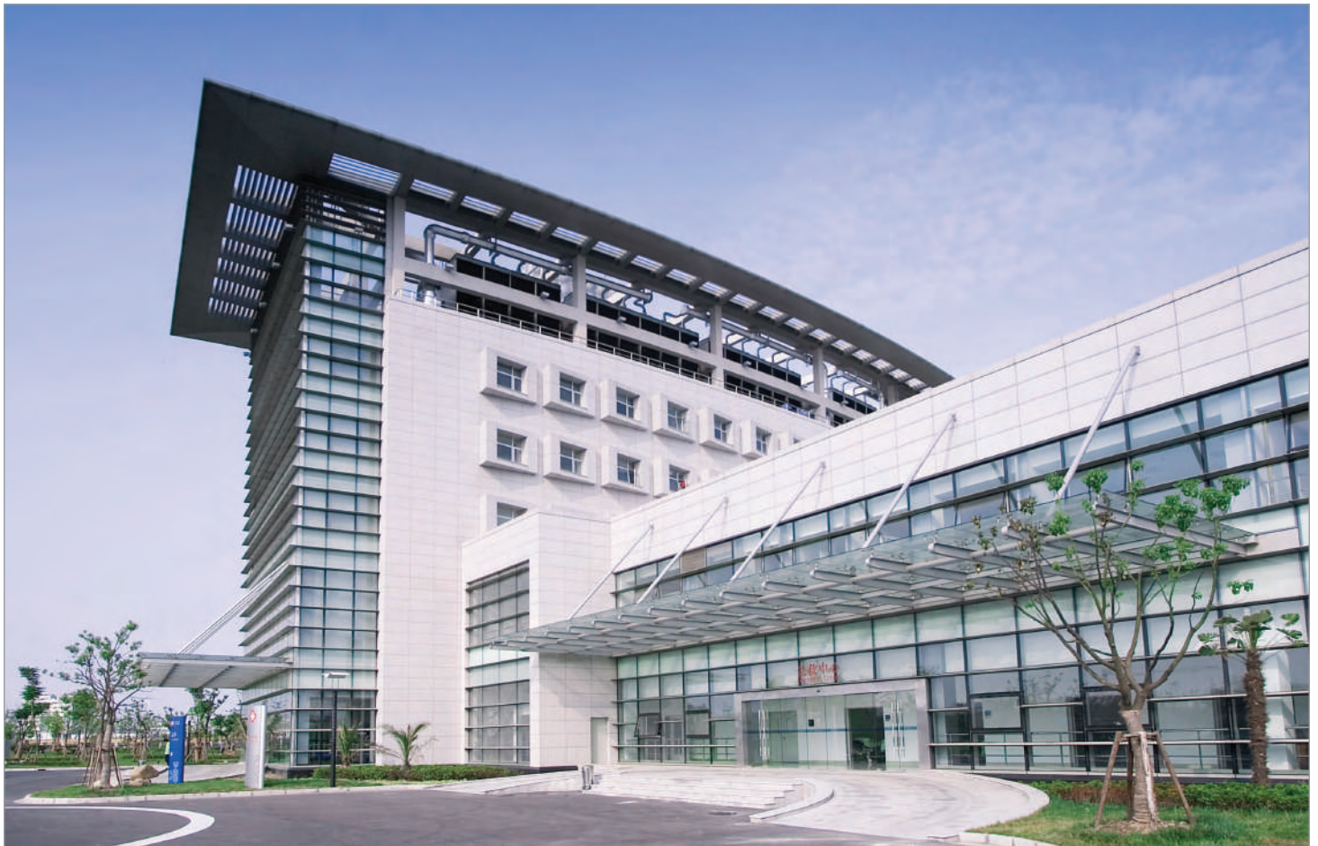
中國上海曙光醫院使用 Danfoss SEM-SAFE® 高壓細水霧系統為其提供消防保護。
