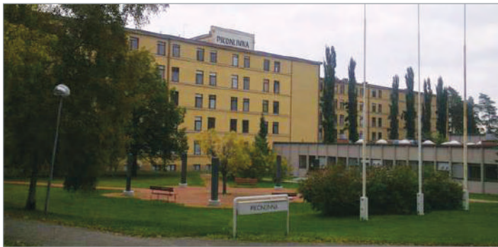
Pikonlinna 醫院採用 Danfoss SEM-SAFE® 高壓細水霧系統提供消防保護。
